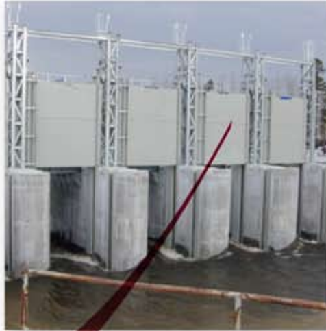
Barrage hydro-électrique • Québec, Canada
