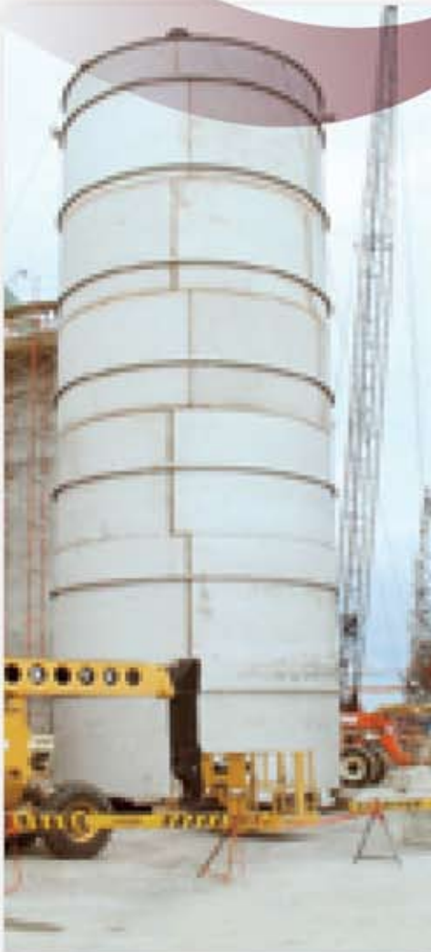
Réservoir • Québec, Canada
