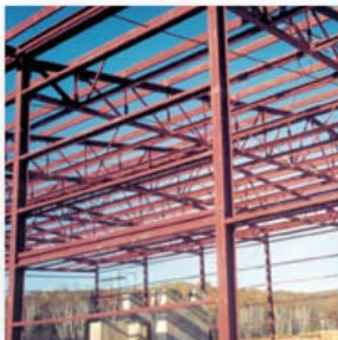
Structure de bâtiment • Québec, Canada
